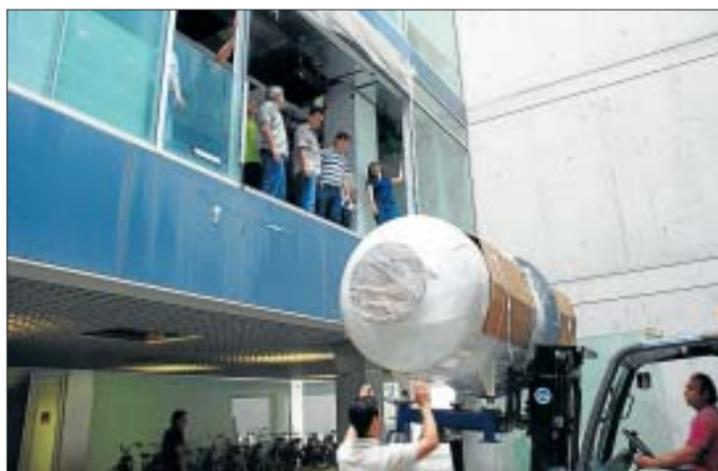
Subida al laboratorio de una cámara de alto vacío de 2 toneladas. UPV
